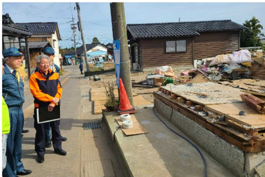
珠洲市蛸島地区の公費解体の視察
